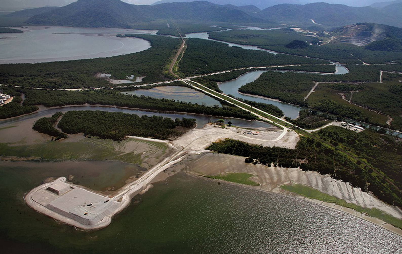
Obras da Embraport, 2009.
